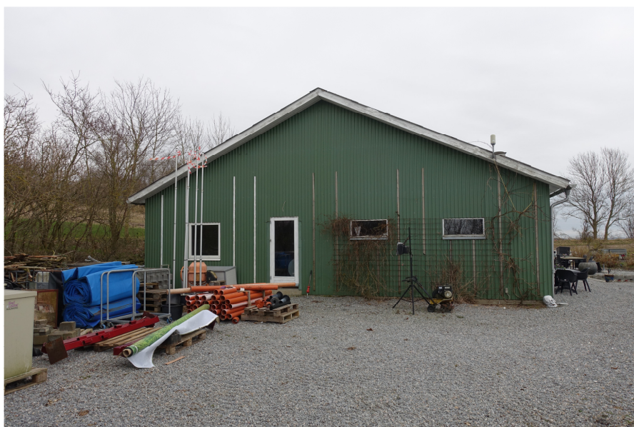
Billede 8 Hal (bygning 4).
