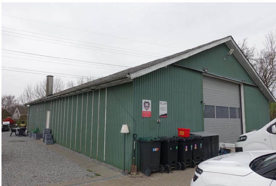
Billede 7 Hal (bygning 4).
