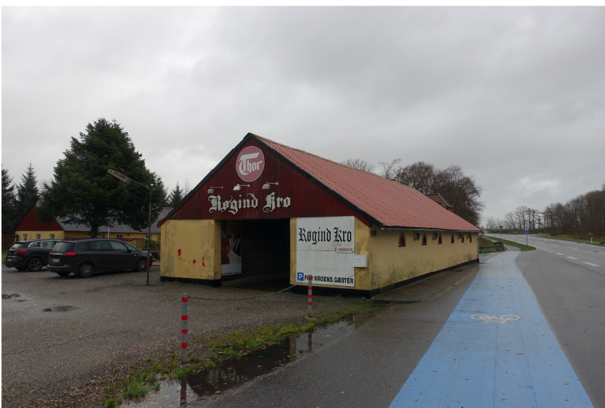
Billede 3 Vognport (bygning 2).
