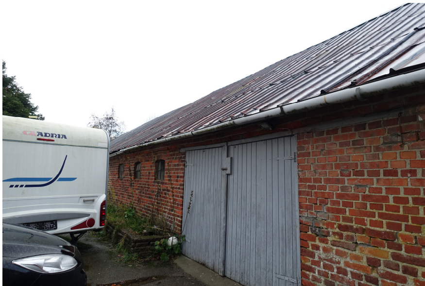
Billede 11 Udhus (bygning 3).
