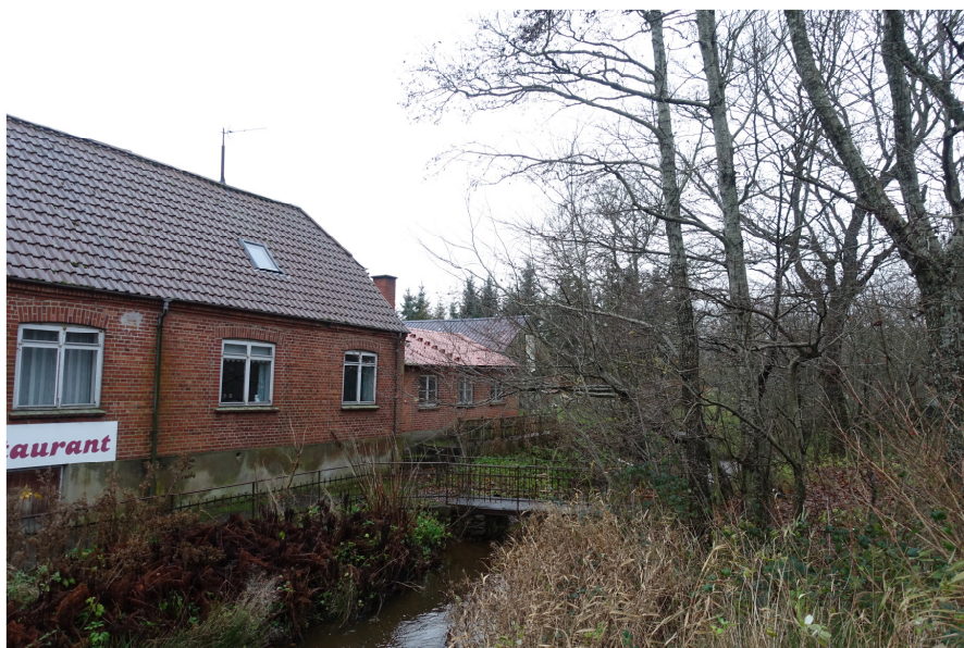
Billede 8 Kro, garage/fyrrum og udhus (bygning 1, 4 og 3).
