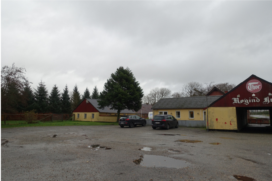
Billede 4 Vognport, Kro og bolig (bygning 2, 1 og 5).
