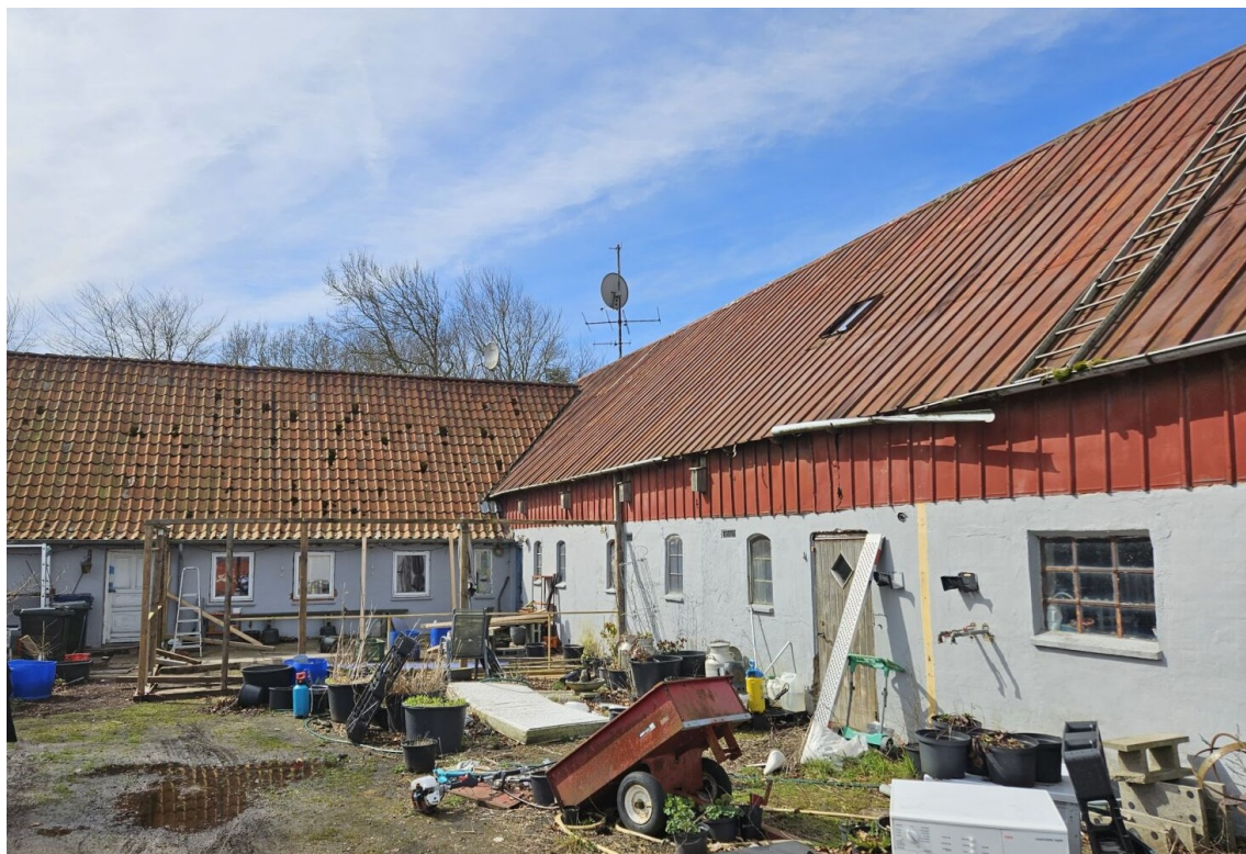
Bygning 1 og 2 set fra nordøst 1.
