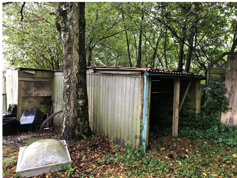
Billede 9 Udhus (bygning A).
