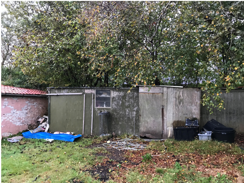
Billede 8 Udhus (bygning A).
