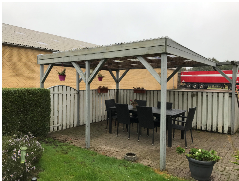
Billede 8 Overdækket areal (bygning B).
