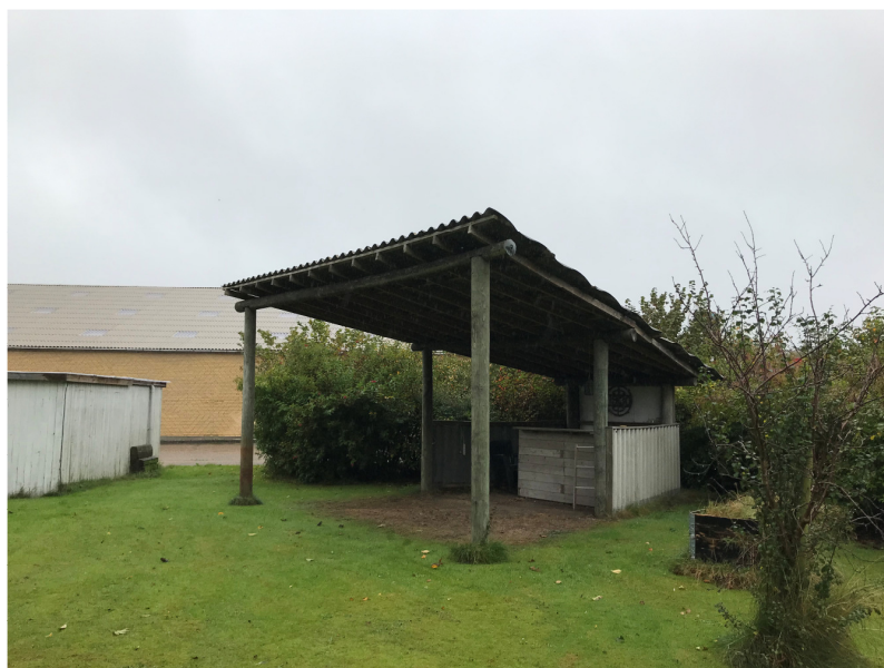
Billede 9 Overdækket areal (bygning A).
