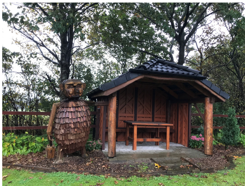
Billede 15 Udhus (bygning D).
