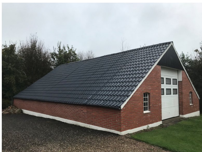
Billede 9 Maskinhal (bygning 4).
