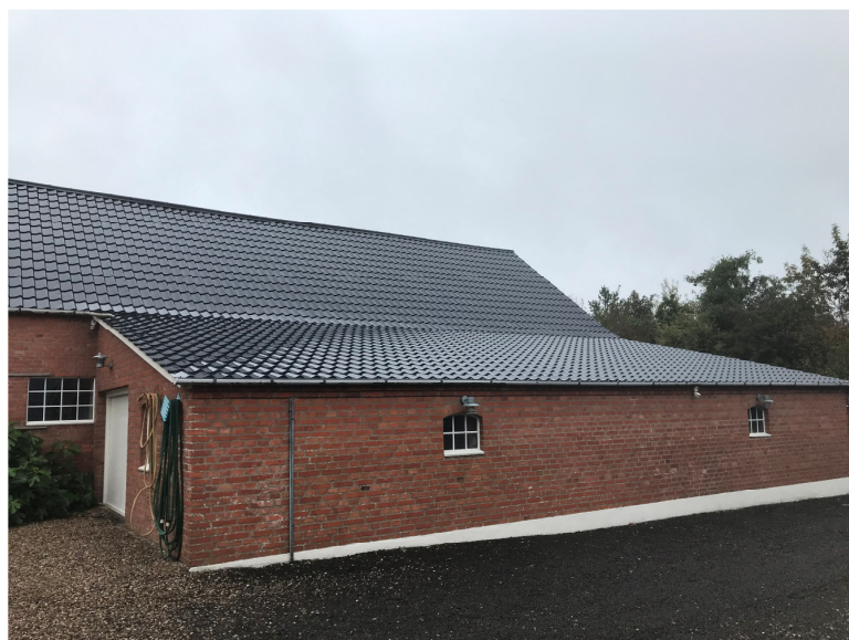
Billede 12 Garage (bygning 5).
