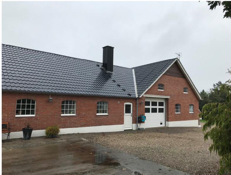
Billede 10 Stald og lade (bygning 2 og 3).
