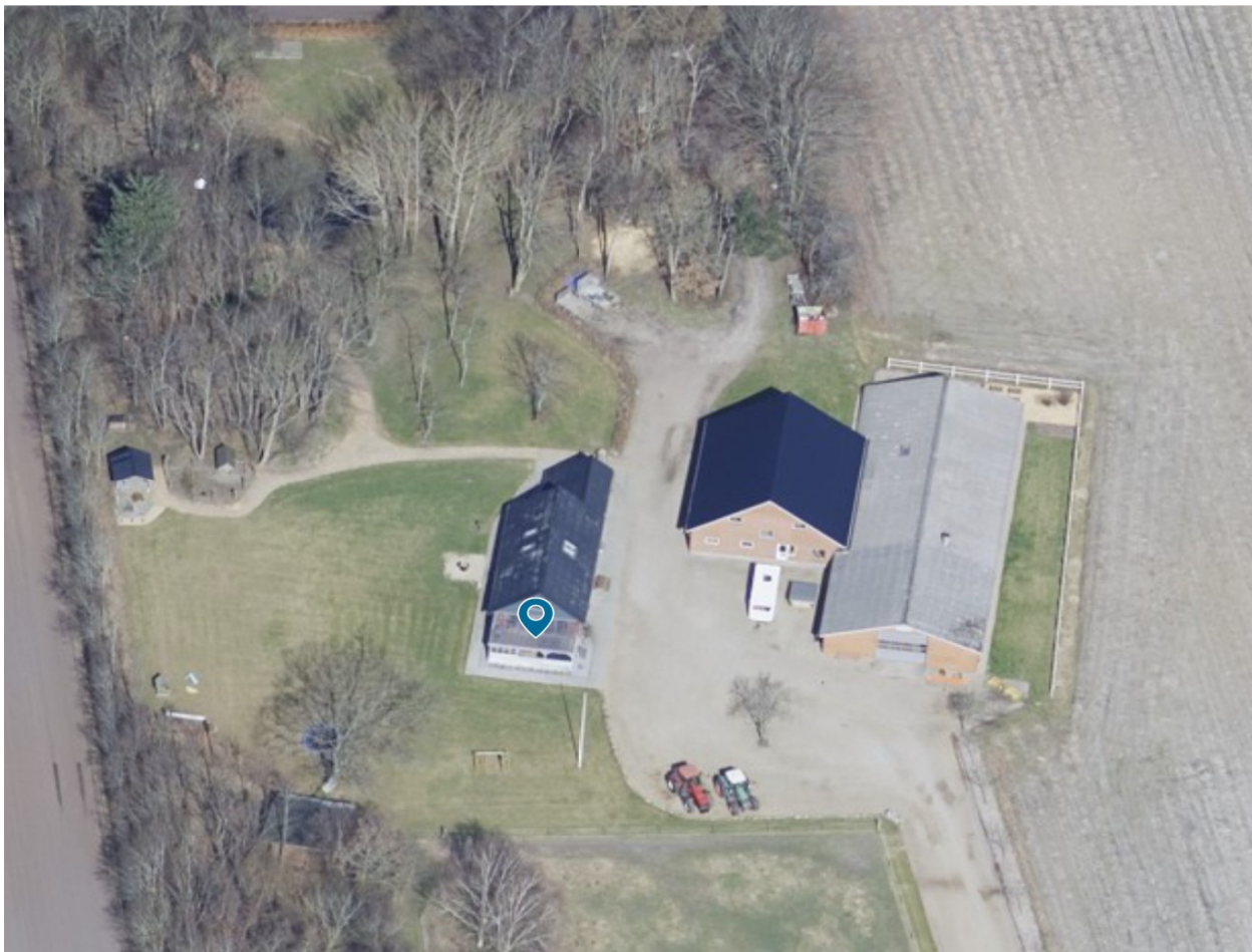
Billede 1 Ejendommen set fra nord
