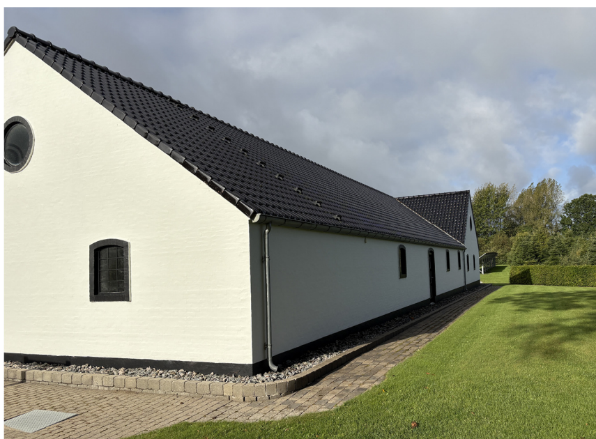
Billede 5 Udhus (bygning 2 og 4)
