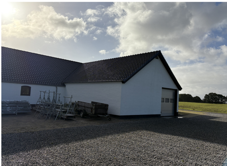
Billede 3 Udhus (bygning 2)
