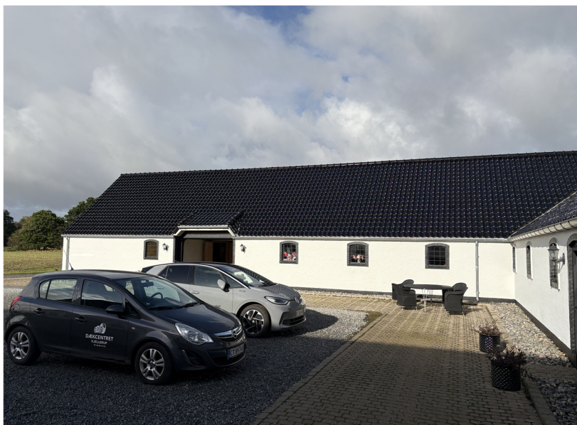
Billede 2 Udhus (bygning 2)
