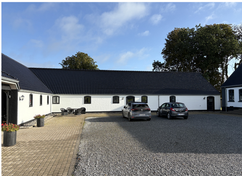
Billede 1 Udhus (bygning 2 og 4)
